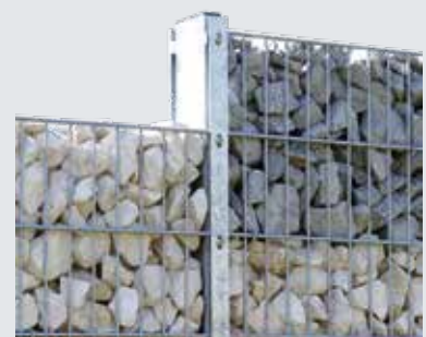
Steinmauer mit feuerverzinkten Pfosten
